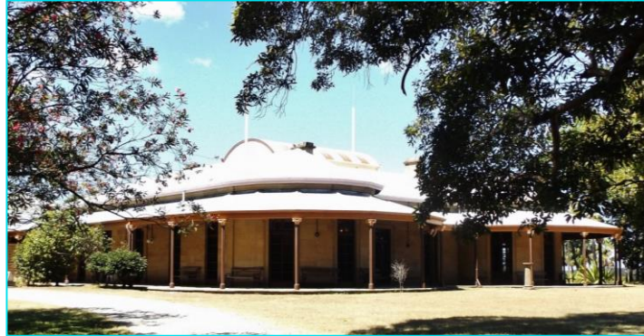
Tomago House 421 Tomago Rd, Tomago NSW 2322
